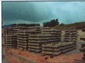
Tapak Projek Depoh Kempas Baru, Johor Bahru - Pengalas Konkrit Yang Akan Di Pasang (23.12.2013)
