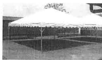
Kanopi yang telah dipasang dan diuji
