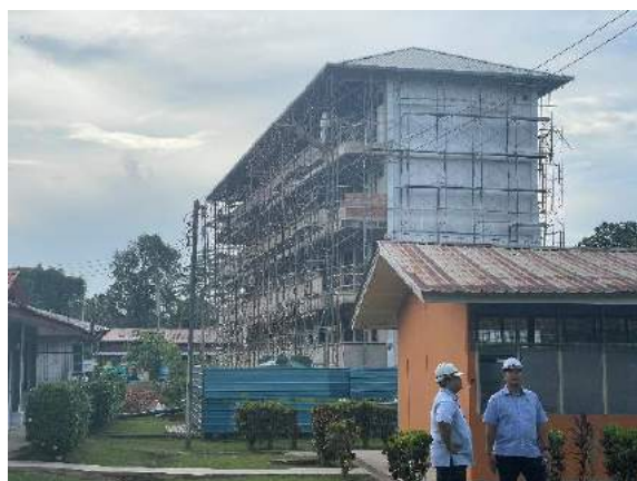
Bangunan blok pentadbiran dalam pembinaan (05.02.2024) (Sumber: PAC Parlimen)
